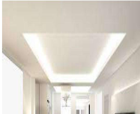
Candileja perimetral en techo con iluminación led cálida
